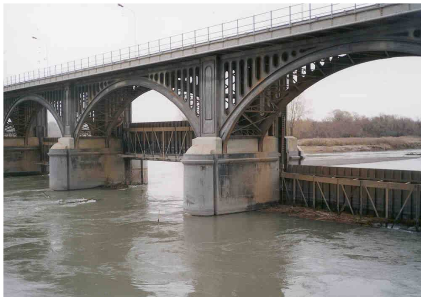
Estación Nº 1 : río Neuquén en el Dique Ballester
